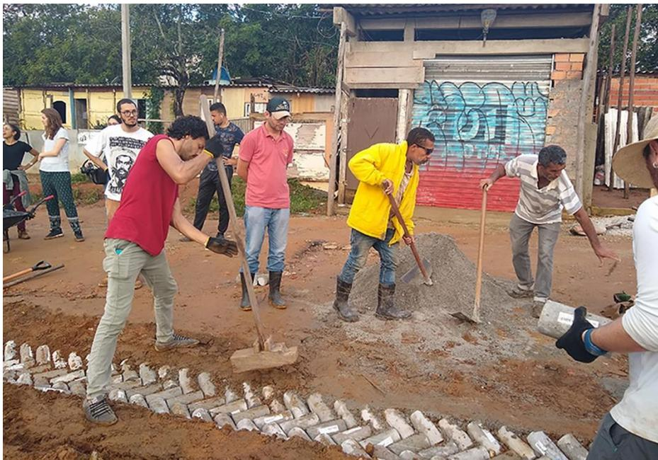
Figura 1: Construção do dispositivo de drenagem no Jardim da União. Fonte: Acervo CPPATHIS, 2019.
